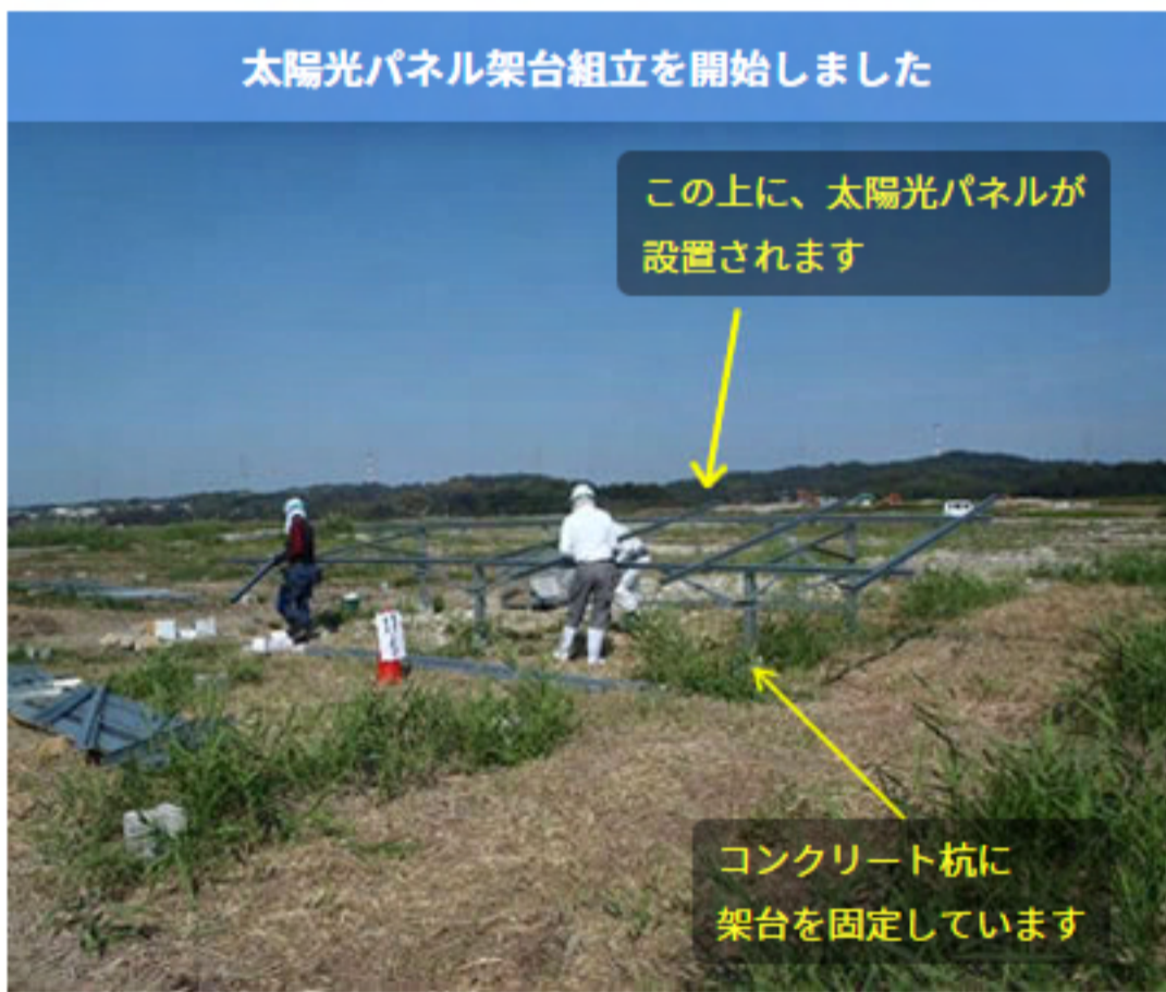
架台組立状況
