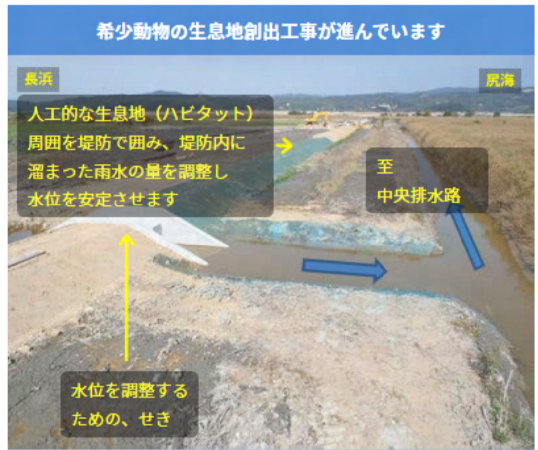
堤防施工状況
