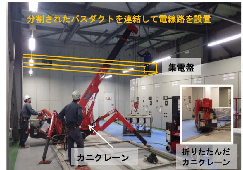
室内が狭いため、バスダクトはカニのような特殊なクレーンで据え付けます。カニクレーンは折りたたむと小さくなり、狭い場所でも入って行くことができます。
