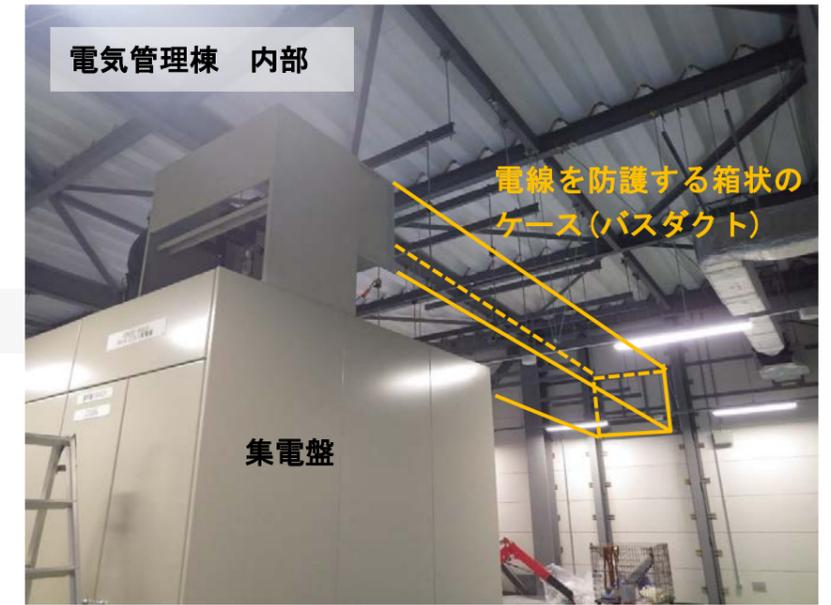
電気管理棟の集電盤から、電線は箱状のケース(バスダクト)の中を通します。
