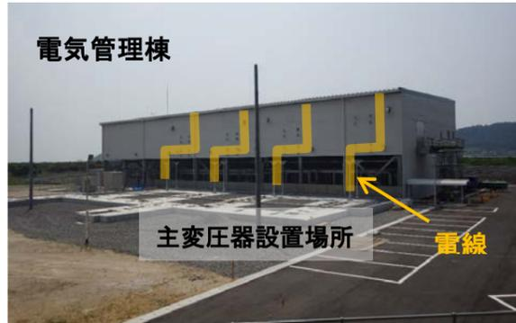
電気管理棟北側に設置する予定の主変圧器。電線（橙色）を設置する工事をしています。（右記）
