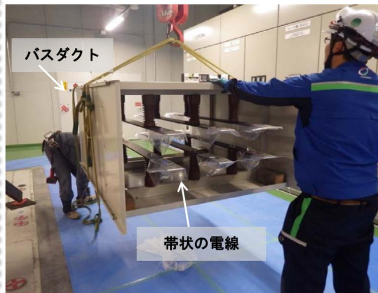
たくさんの電気を流すため、電線はアルミニウムでできた带状の太い電線を使用しています。分割されたバスダクトを継ぎ合わせて、電線路を作ります。
