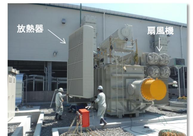
熱を持つ鉄心を冷やすため、内部の油を冷却する装置(放熱器)を設置している様子です
