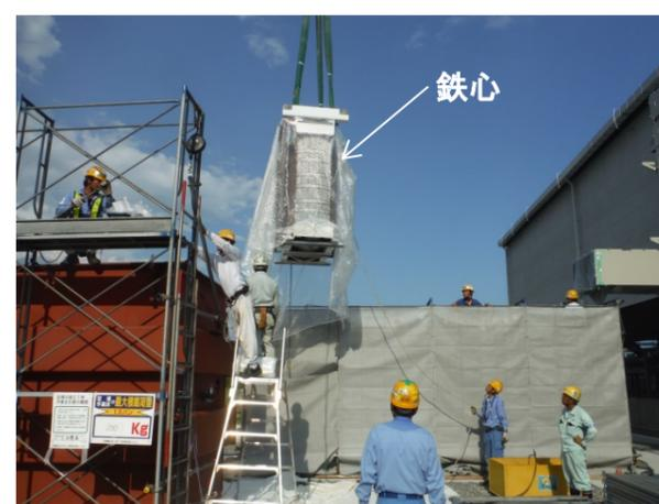
主変圧器の内部に電圧を上昇させるための鉄心を設置している様子です
