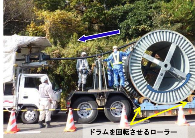
ケーブルを引込む側では、先端にケーブルを固定したワイヤーをウインチで引っ張ります。
