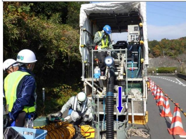
シーブ車のボールローラーは2個のゴムボールでケーブルを挟みボールを回転させてケーブルを強制的に送り出します。
